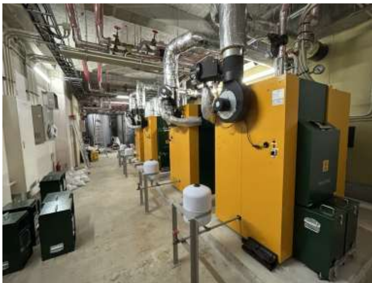
リードパークリゾート八丈島で稼働中のバイオマスボイラー
