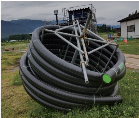
ロール状の温水供給熱導管 最大長は関係によって異なる
